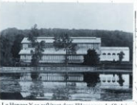
Le Hangar Y se reflète dans l'Hexagone de Chalais
