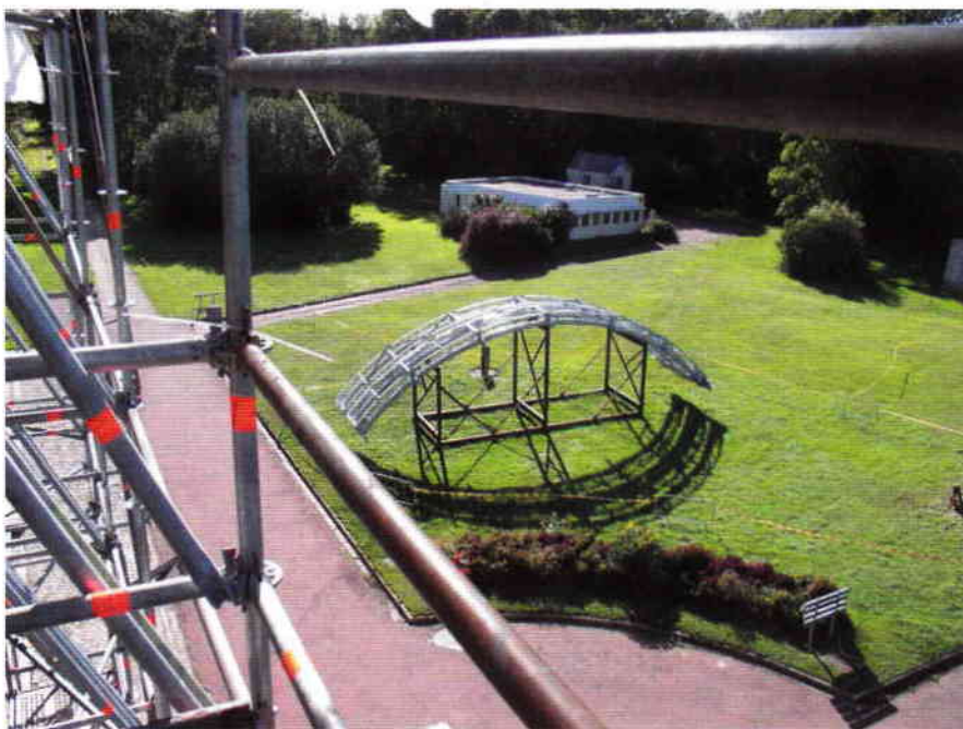
Nouvelle trappe en attente d'équipement mécanique, de peinture et de couverture avant repose. © Observatoire de Paris
