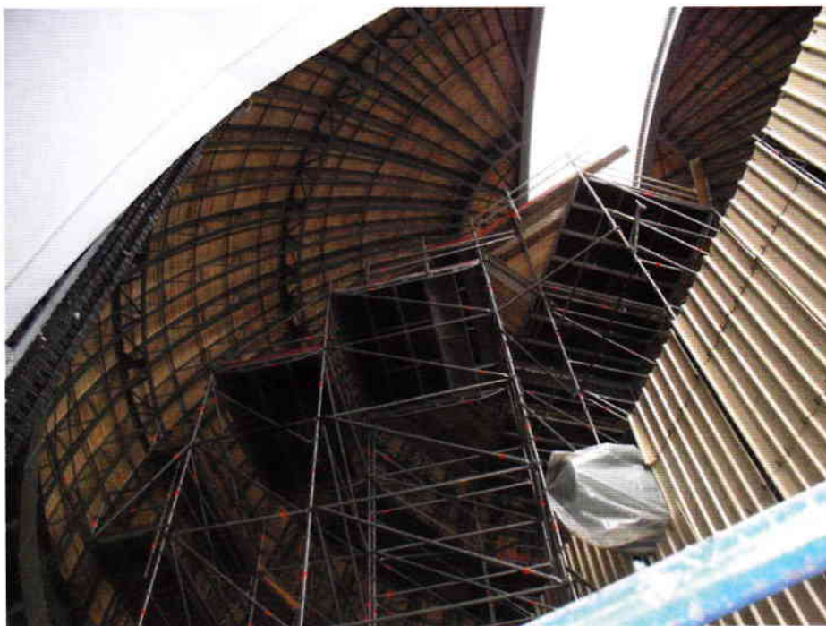
Intérieur de la coupole après travaux. © Observatoire de Paris
