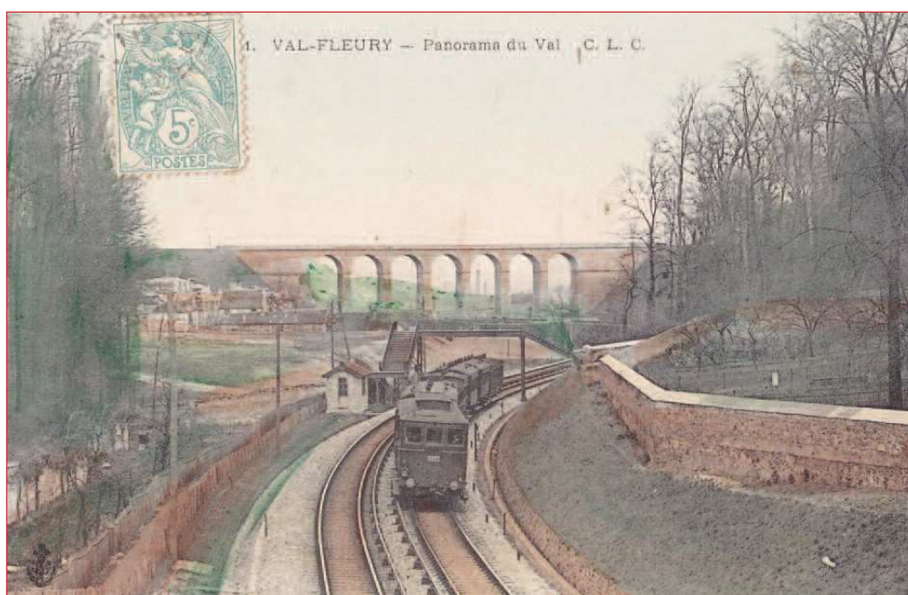
Au premier plan la ligne des Invalides, et, au fond, le viaduc de la ligne vers Montparnasse.
